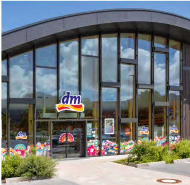
Für den Bau des dm-Markts in Bernau am Chiemsee wurde unter anderem Holz der heimischen Lärche genutzt, um den Bezug zur Region herzustellen.
